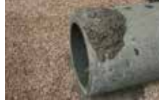
teils oder komplett einbetoniertes Rohr
