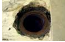
bündig abgeschnittenes Rohr
