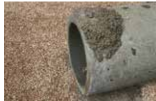
Teilweise oder komplett einbetonierte Rohre
